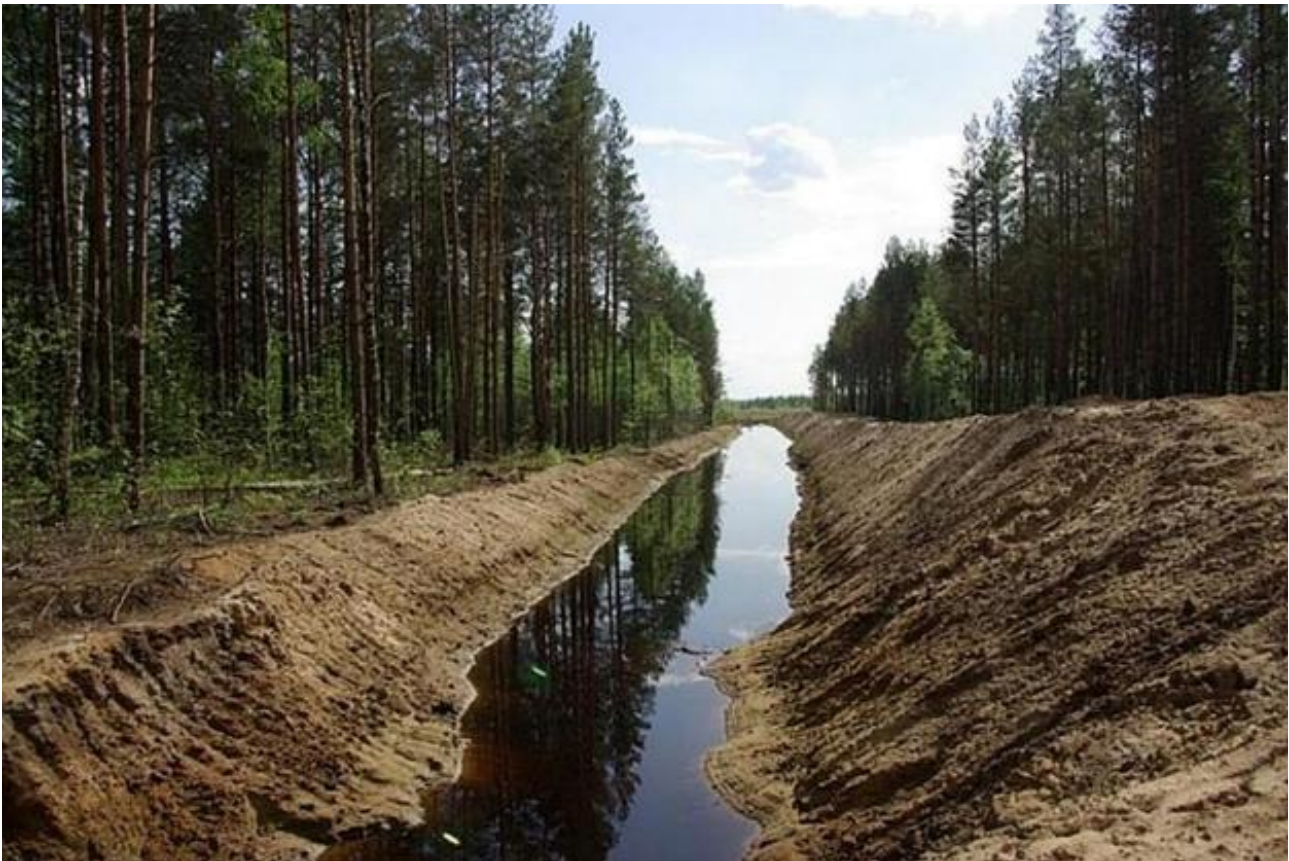
Рис. 54. Осушительный канал в лесном массиве [15]
